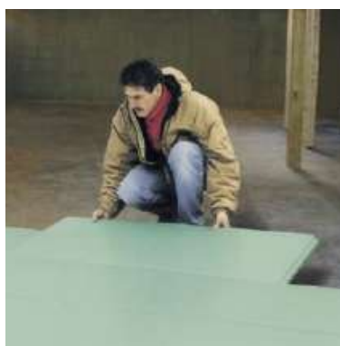
Dämmung Kellerfußboden
