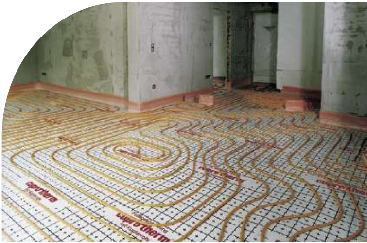
Fußbodenheizung
