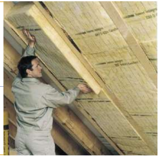
Dämmung Dachschrägen
