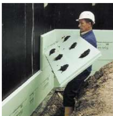
Perimeterdämmung
