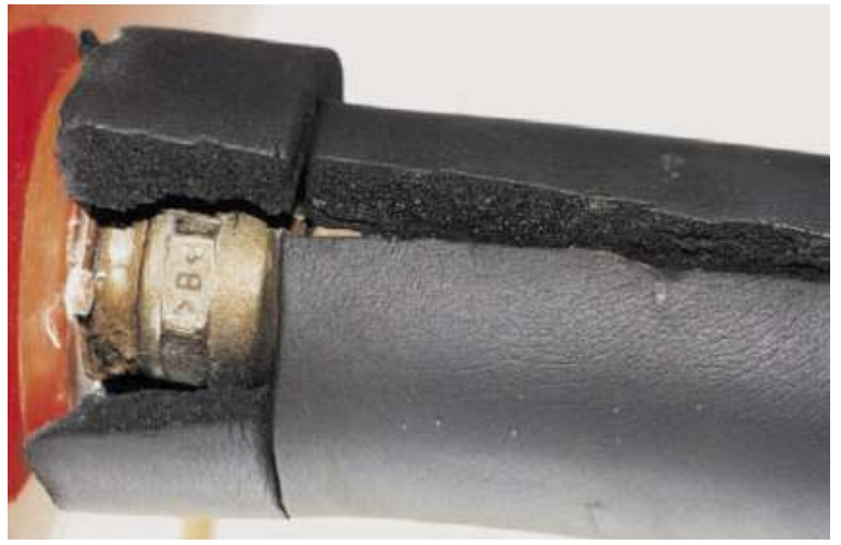
Mangelhafte Rohrdämmung
