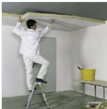
Dämmung Kellerdecke
