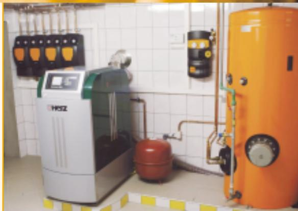
Pellet-Zentralheizungen werden im Heizungsraum eines Gebäudes installiert. Im Fachhandel sind sowohl halb- als auch vollautomatische Pellet-Zentralheizungen erhältlich. Die halb- und vollautomatischen Heizungstypen unterscheiden sich im Platzbedarf des Aufstellraumes und im Arbeitsaufwand zur Befüllung von Vorratsbehälter und Lagerraum.
