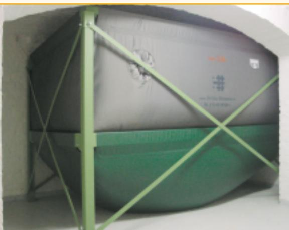
*Abb. 7: Diese vollautomatische und geregelte Pellet-Zentralheizung mit einer Leistung von 24 kW versorgt ein 2-Familienhaus mit insgesamt 280 m<sup>2</sup> Wohnfläche. Der benötigte Pelletvorrat von ca. 9 t wird in einem Gewebetanksilo gelagert. Quelle: [www.aktion-holzpellets.de](http://www.aktion-holzpellets.de)*
